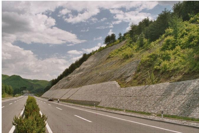
Obr.14: Ochrana proti sesuvům skal pomocí sítí
